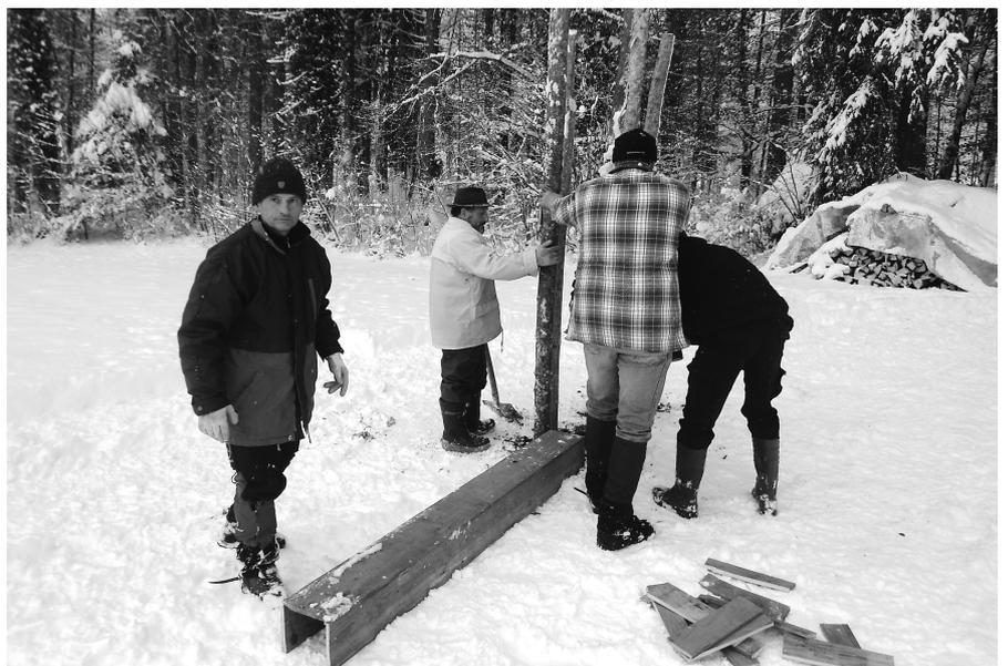
Remo Berchtold, Fritz Halter und zwei Helfer beginnen den Aufbau des Meilers. Am Boden der Zuluftkanal.
